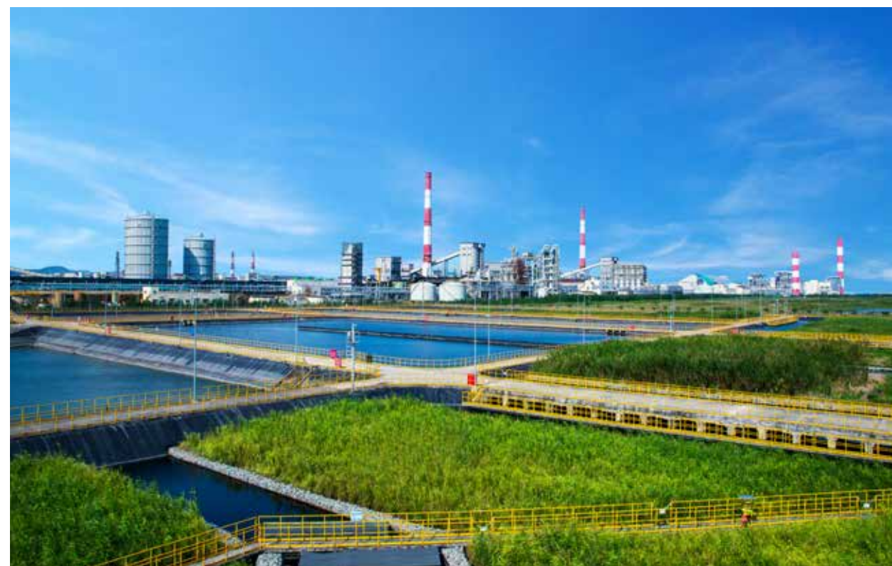
..... 台塑河靜鋼鐵公司
