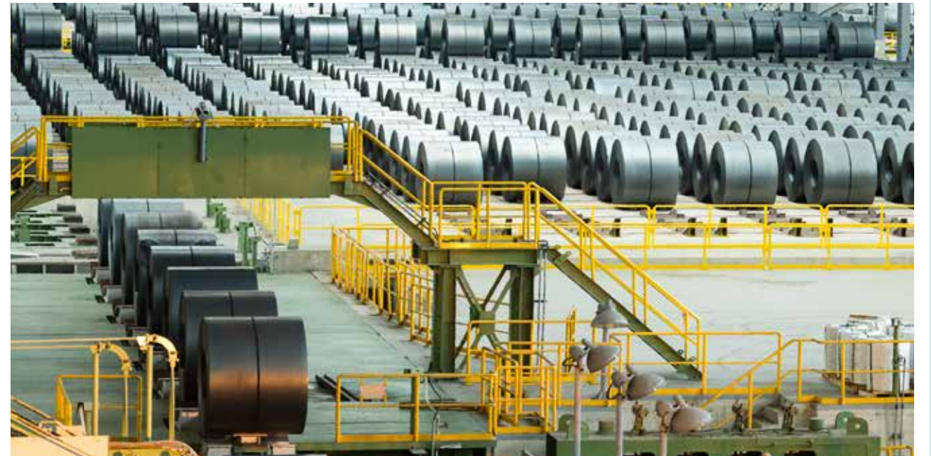
台塑河靜鋼鐵一熱軋廠
