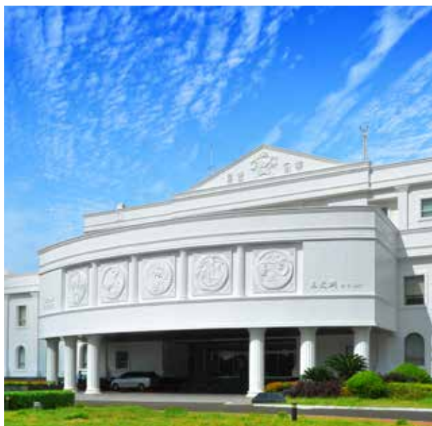
..... 麥寮園區 行政大樓
