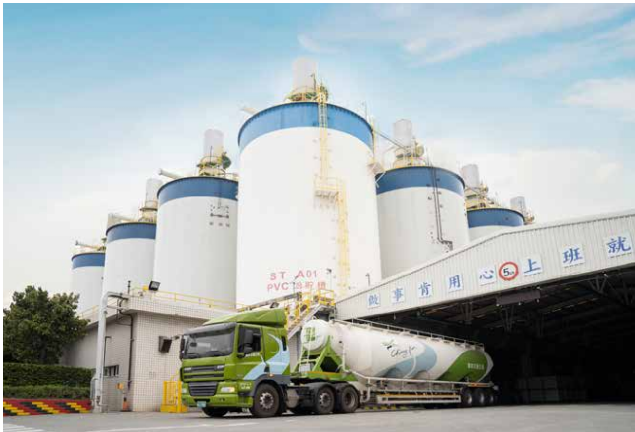
..... 麥寮廠區 PVC 廠
