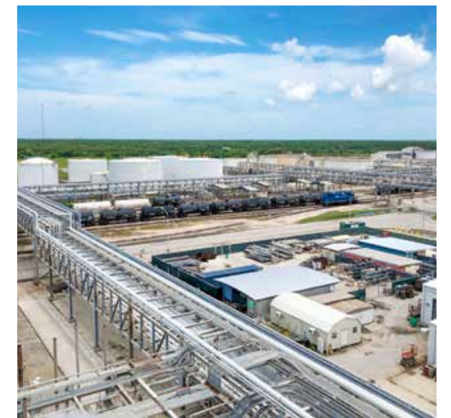
美國德州廠區乙二醇鐵路車裝載站
